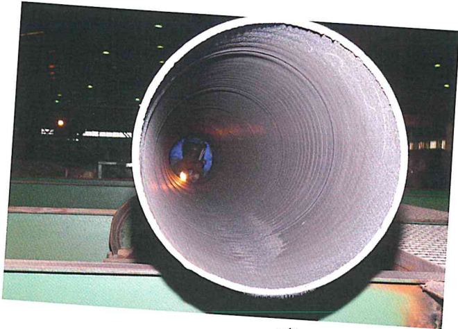
عملية اللحام الداخلي للأنابيب
