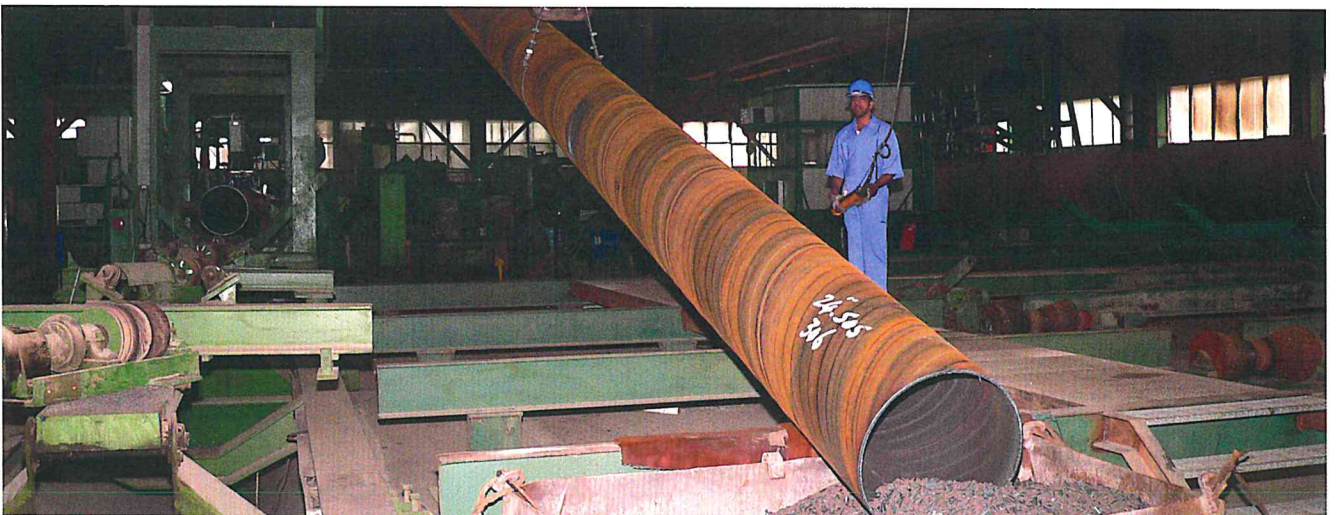
عملية التنظيف الداخلي للأنابيب
