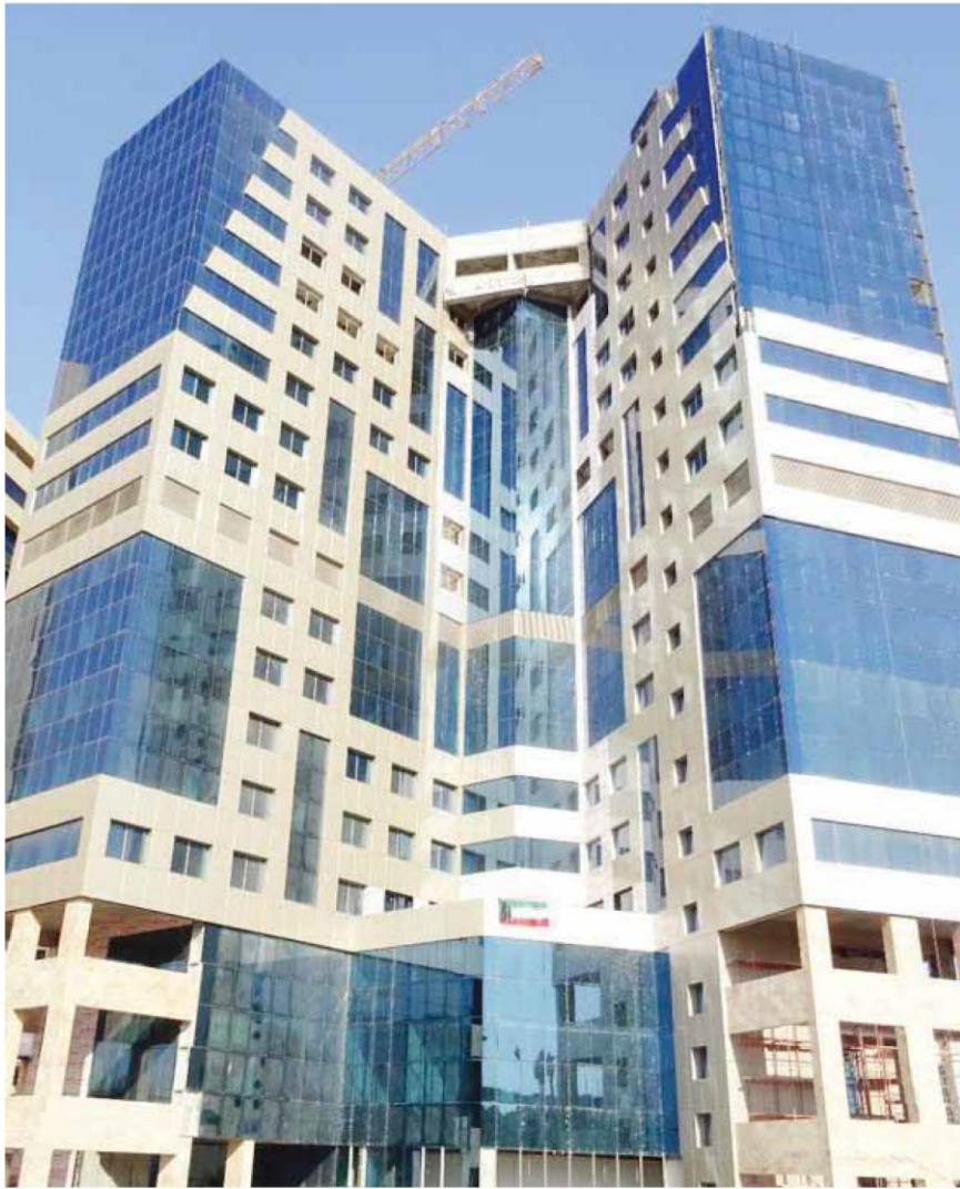
مشروع مبنى إدارة الخبراء الجديد المرصع تسليمه الفترة المقبلة
