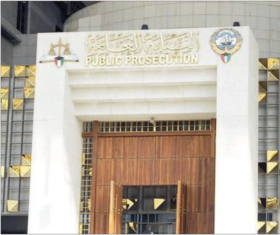
مدخل مبنى النيابة العامة
